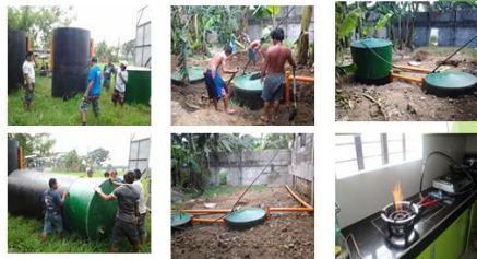
Pagkakabit ng Floating Type Biogas Digester sa isang slaughterhouse sa G.M.A. Cavite
